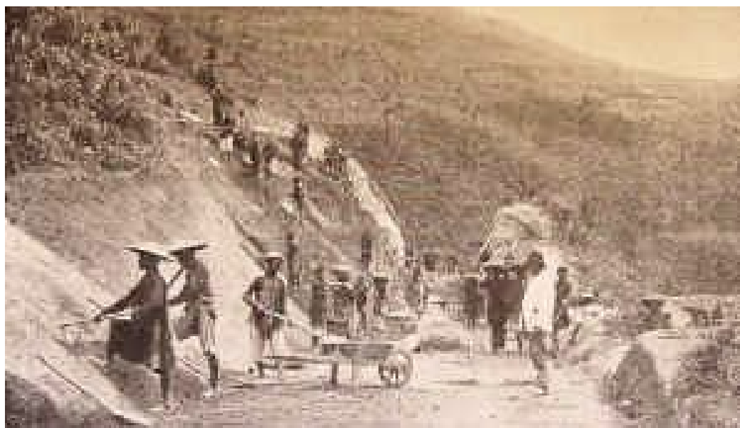
Travaux de voirie au Tonkin (anonyme, s.d.)
